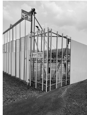
建設が始まった岩瀬の生涯学習センター、図書館
