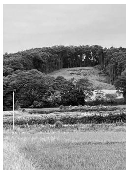
羽田山は植生豊かな里山、その一画、西山地区で進む太陽光発電施設
